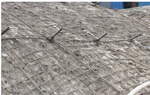
图2 土钉支护施工技术
