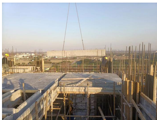
图3 现场吊运施工
