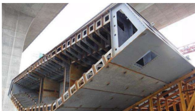
图2 钢纤维混凝土在桥梁面板制作中的应用
