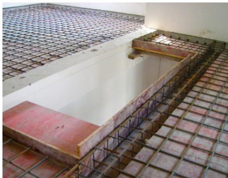
图2 大型钢结构厂房钢结构夹层
