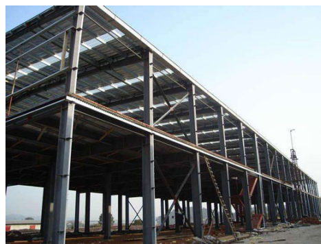
图1 大型钢结构厂房钢结构框架
