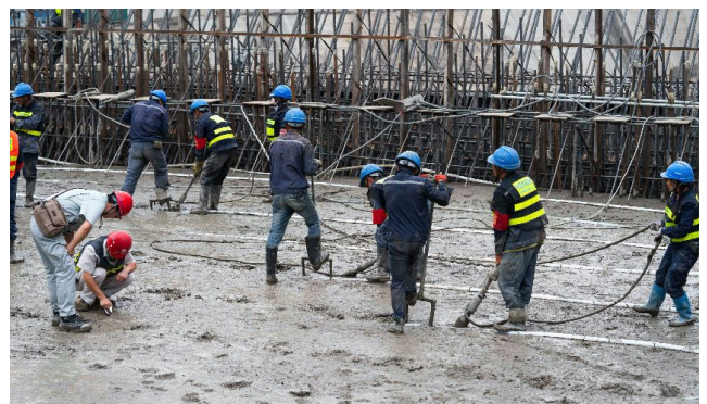
图1 水利水电工程施工现场
