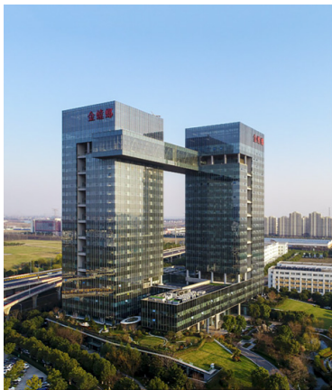
图1 大跨度连廊吊顶
