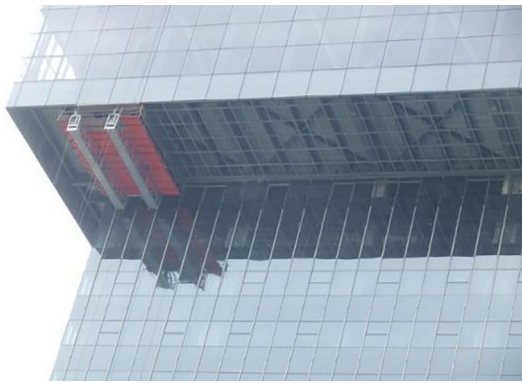
图4 双吊篮组合移动式吊顶施工平台
