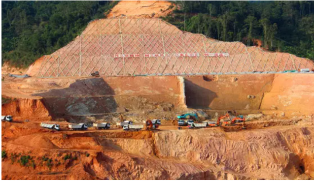
图2 土坝防渗加固施工技术在水利水电建筑施工中的应用
